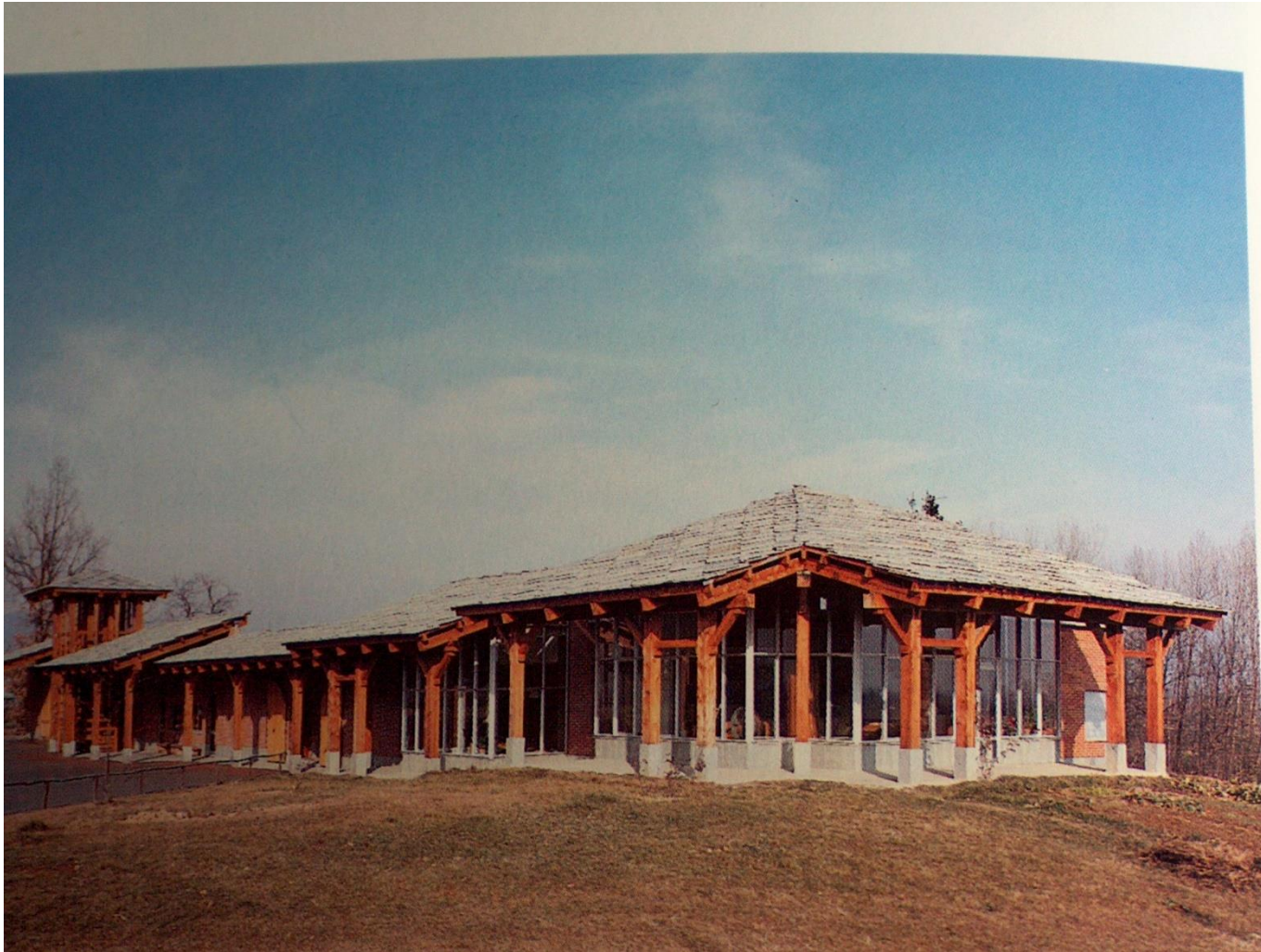
CASEIFICIO A BAGNOLO PIEMONTE Realizzata da Gabetti e Isola nel 1982
