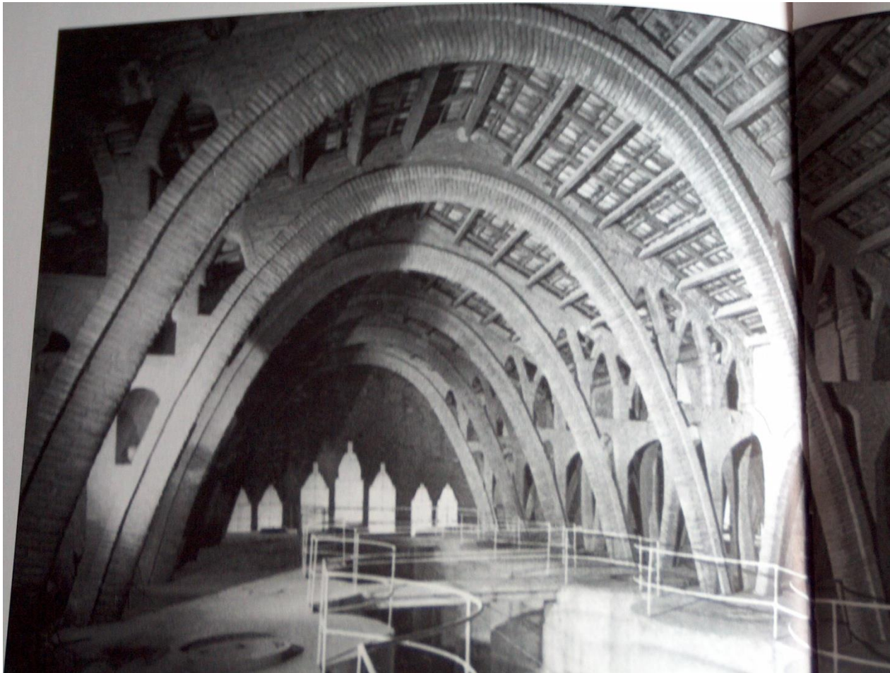
MAGAZZINO DEL SINDICATO AGRICOLA DI ROCAFORT DE QUERALT
